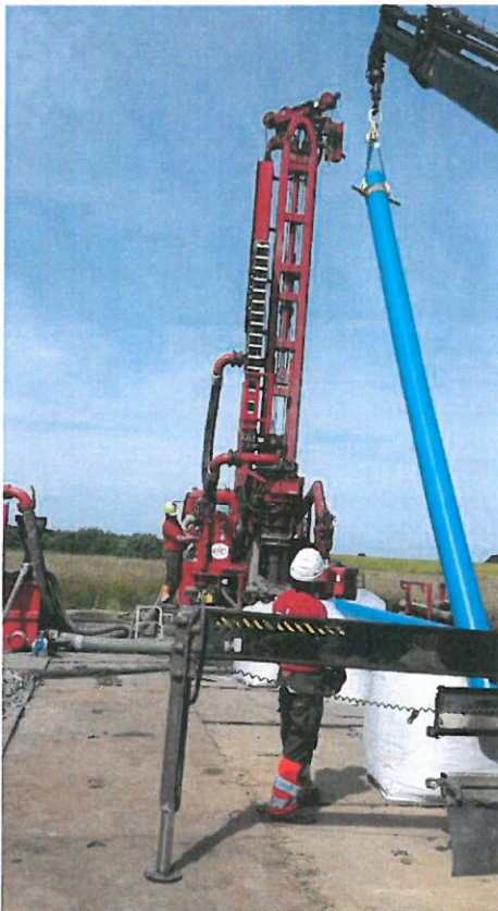
Borerig i gang med ny drikkevandsboring til Lem vandværk
