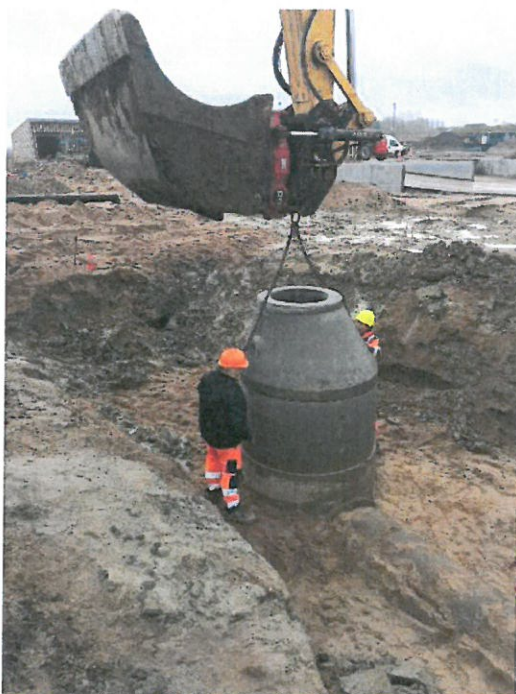
Etablering af kloak i GreenLab Skive.
