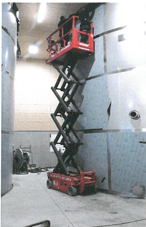
Svejsning af 2 rentvandstanke i rustfrit stål på Lem vandværk. Hver tank kan rumme 350 m 3 .
