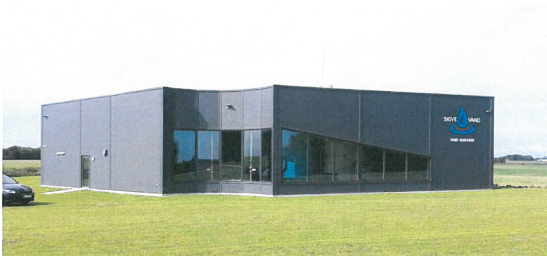
Det nye Vihøj vandværk nord for Breum, som blev taget i brug i 2017.
