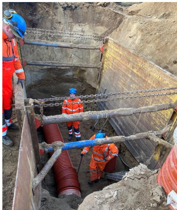
Viborgvej i Højslev. Spildevandsledning i stor dybde.
